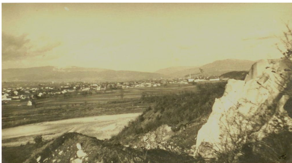
Ryc. 3. Skalka Kielbasowa, kamieniołom, zachodnia strona Dużego Grojca (fot. K. A. Nowak, 1947).
